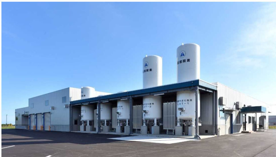
総合充填所の外観
