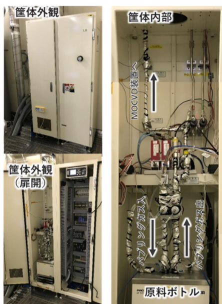
図1. 低蒸気圧原料供給ユニット
