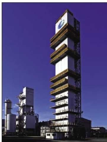
図1 18 O濃縮プラント外観
