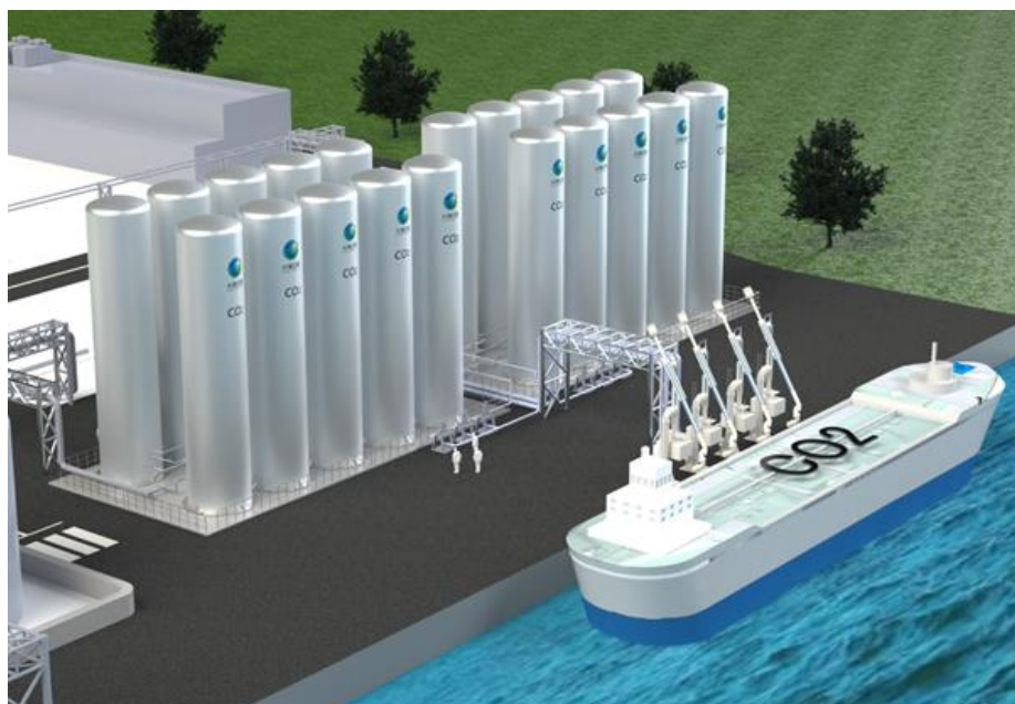
CCS用CO 2 出荷タンク設備（イメージ）
