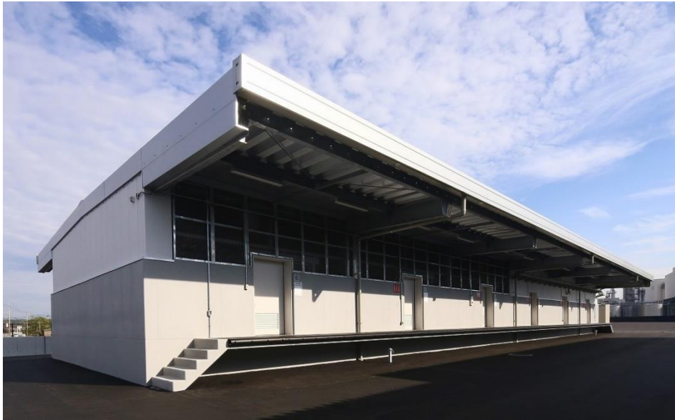
特殊ガス容器の保管施設外観
