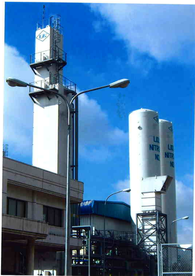
No.2 大型空気分離プラント
