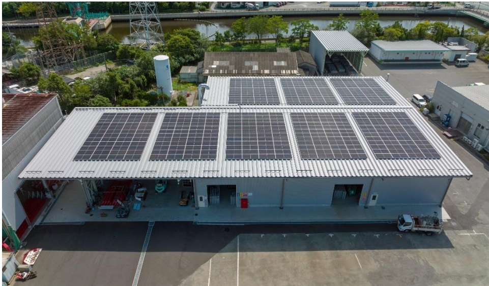
総合耐圧検査場 上空写真
