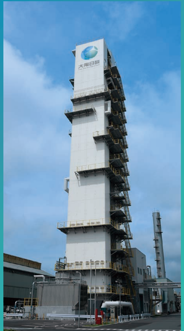
Water- 17 O製造プラント
