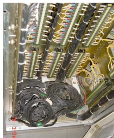
図5 従来技術を用いた電気設備と FCS 間の配線例 (盤下部に向かう多数の配線が DCS との通信配線)
