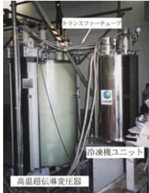
図4 連続式過冷却液体窒素冷却システム
